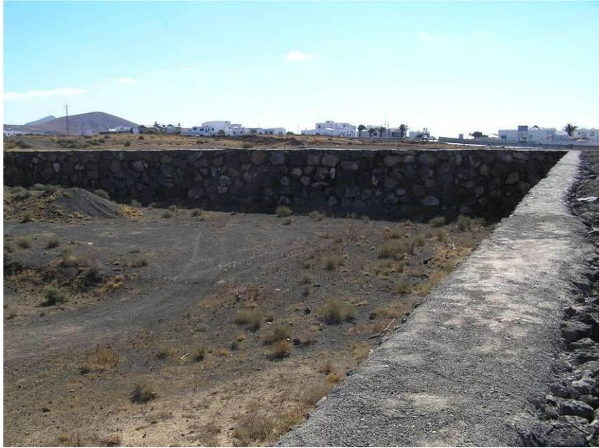
Figura 16. Muro de contención en área extractiva. Gesplan. Trabajo de Campo 2009.
